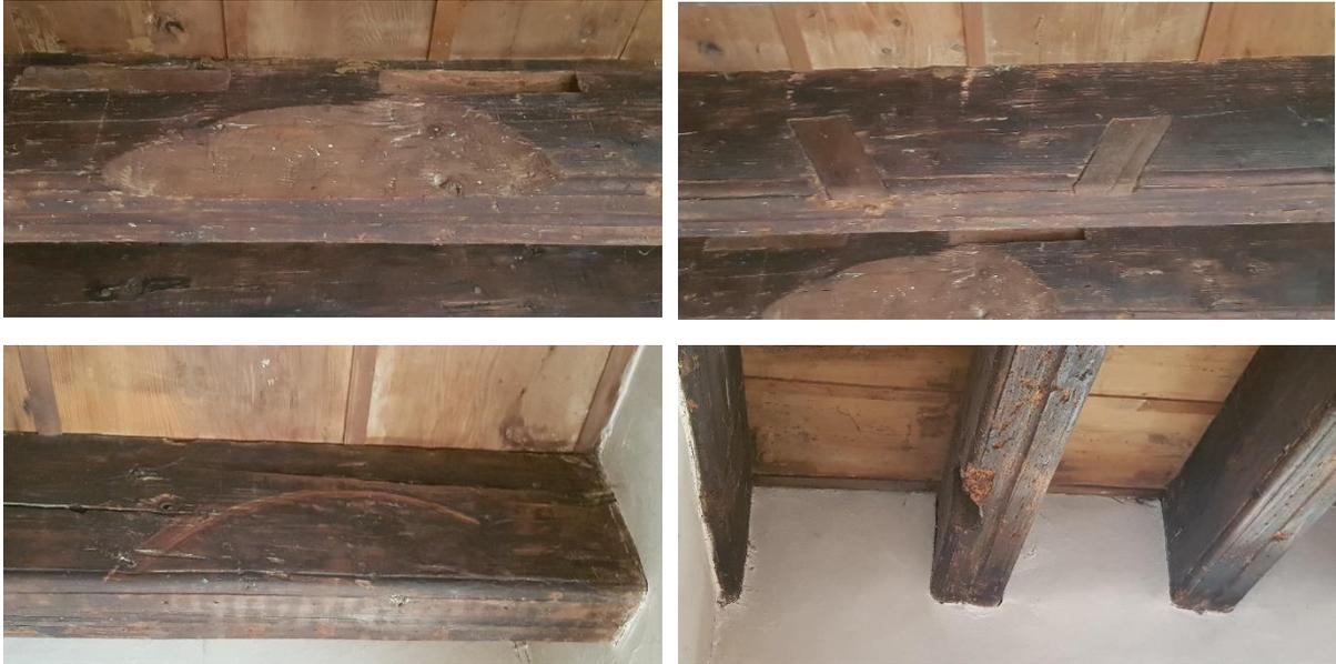
Traces de fixation de cales ou colonnes dans les poutres de l'appartement rez sud
