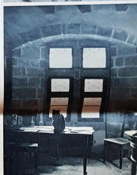
l'épine dorsale de tout ce corps de bâtiment. Photos de droite: M. Müller opère avec précision, patience et adresse. Il monte la fenêtre avec des pierres trouvées dans les murs qui ont été taillées sur place. Enfin, vue de l'intérieur, la fenêtre terminée. Les vitres serties au plomb ont exigé de longues recherches; pour finir, on a utilisé du verre blanc mais passé au four pour obtenir des déformations et des irrégularités de surface. (Photos Yves Debraine, Drilhon)
